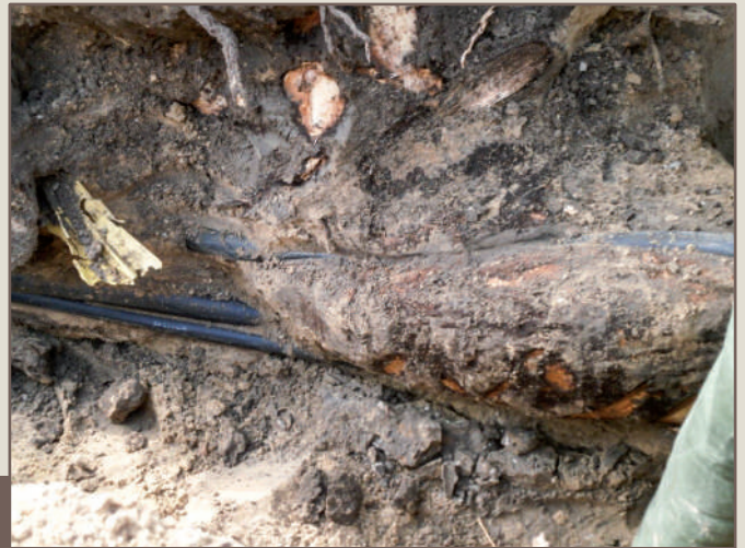
A fák gyökérzete tönkretette a járdát, és veszélyeztette a közművezetékeket.
